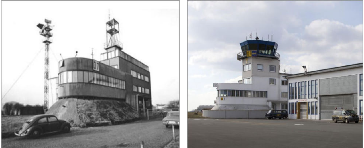
Abbildung 16: Flugleitgebäude - Vorher und Nachher (Quelle: Baukunst-NRW, FEM GmbH)
