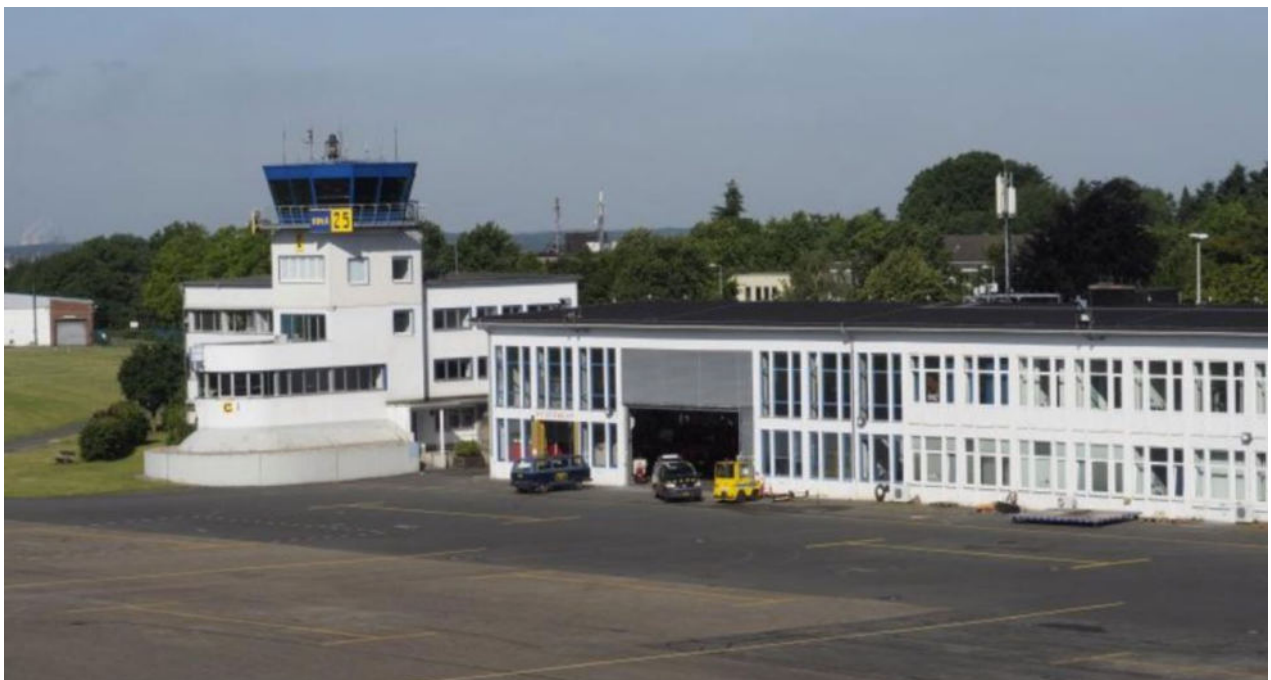
Abbildung 15: Flughafenrestaurant (Quelle: FEM GmbH)
